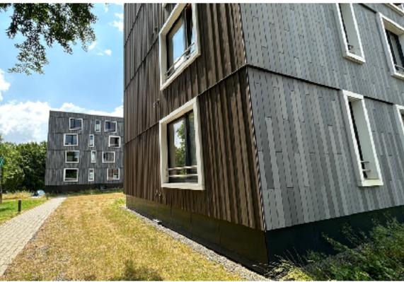
Diese Bauweise stellt insbesondere an die Haustechnikplanung sehr hohe Anforderungen hinsichtlich der Schachtbildung durch die statischen Einschränkungen. Auch die Vorhangfassaden mußten detailliert auf den Einbau der Lüftungsgeräte in den Fassaden vorbereitet werden.
