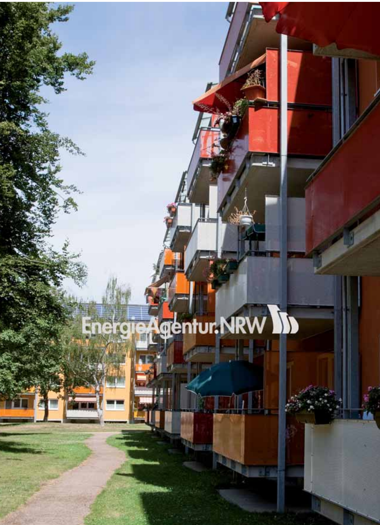
Steigerung des Wohnwertes durch vorgestellte Balkone
