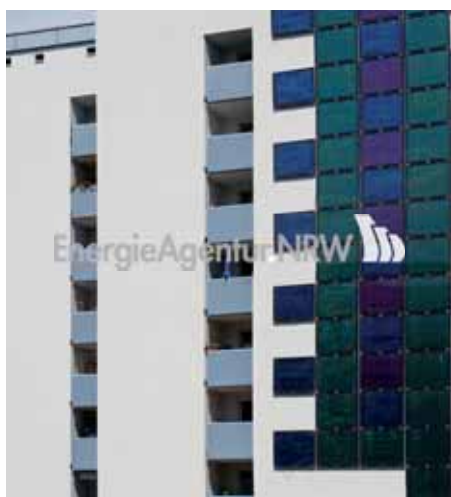
Photovoltaikmodule als fassadengliedernde Elemente.
