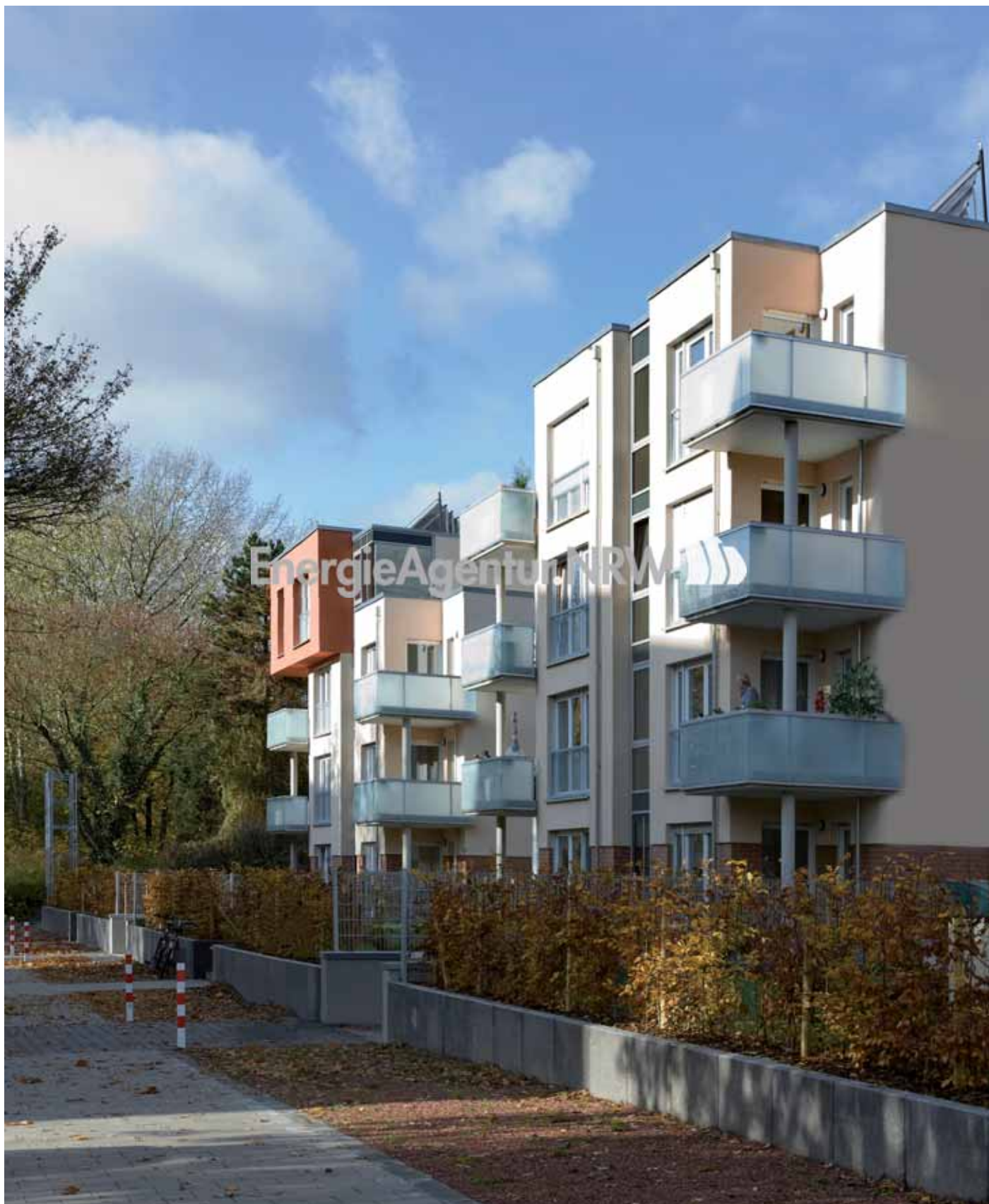
1. Bauabschnitt – Die kubische Architektur antwortet auf die Blockstruktur
