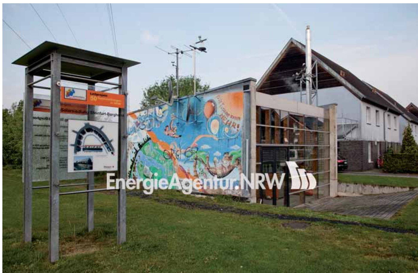
Der Solarpoint und im Hintergrund die Heizzentrale.
