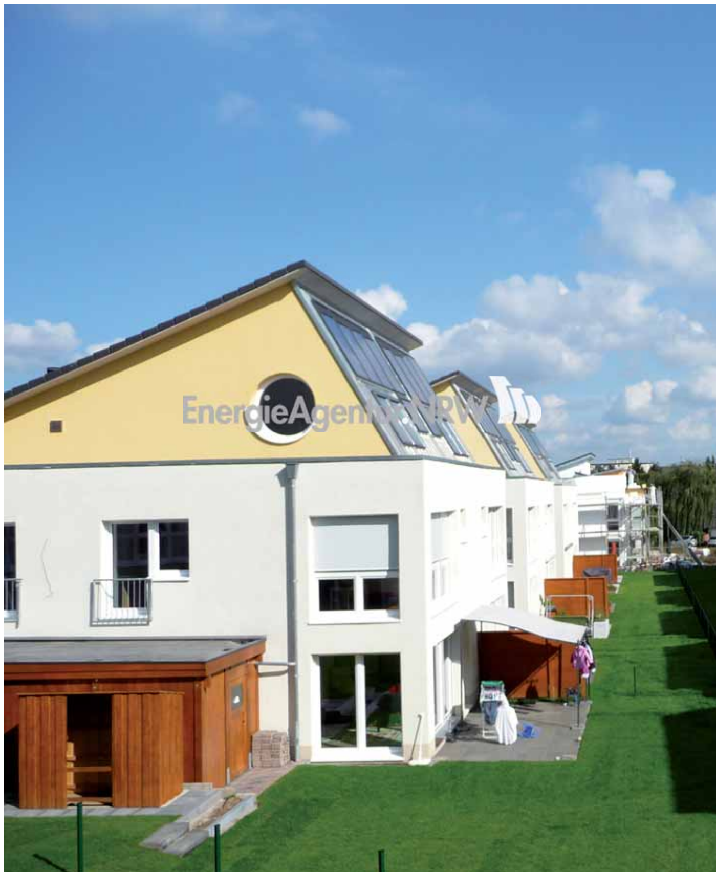
Die Pultdächer nehmen die Solaranlagen auf.
