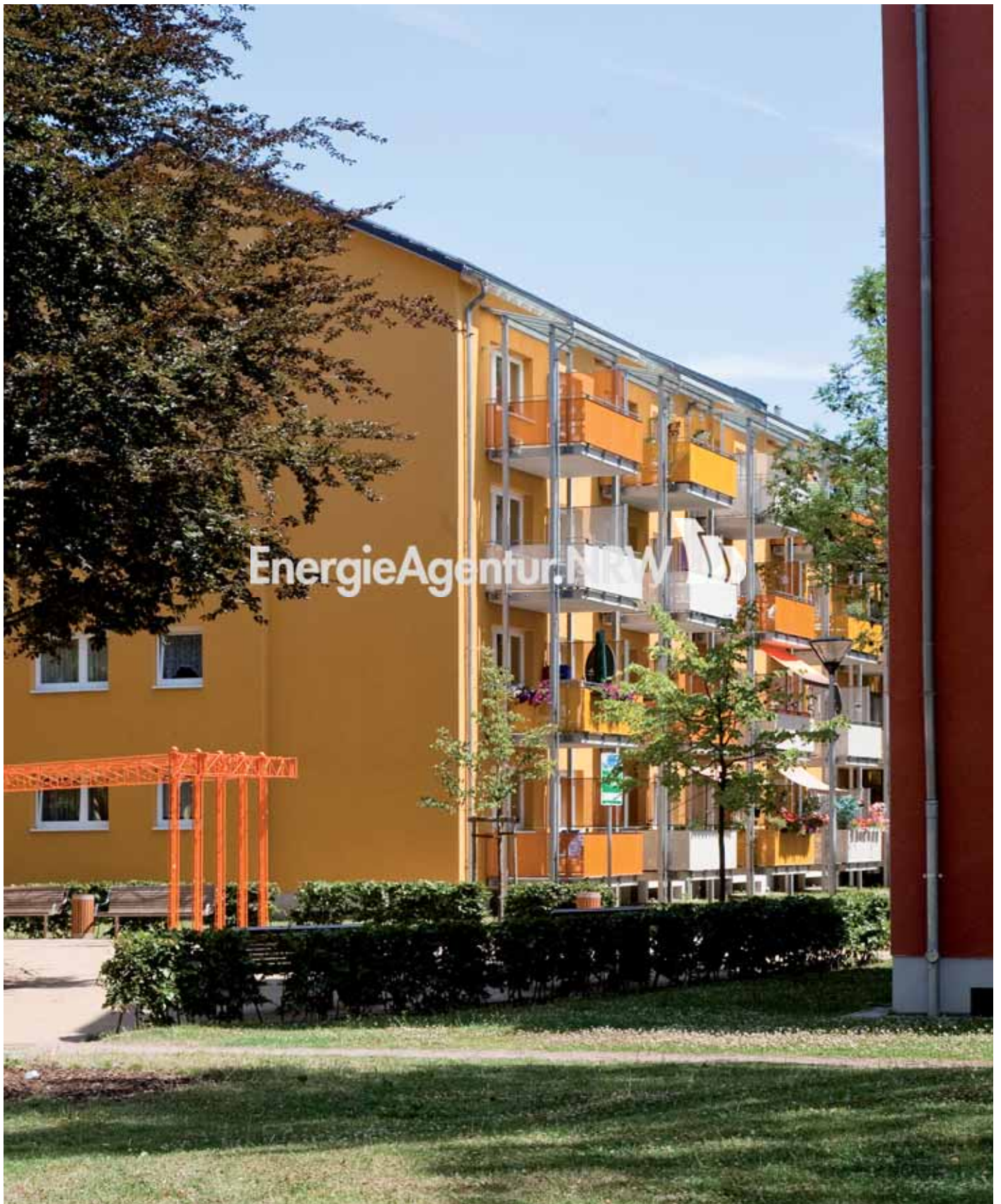
Die neuen Balkone sind die verlängerten grünen Wohnräume.
