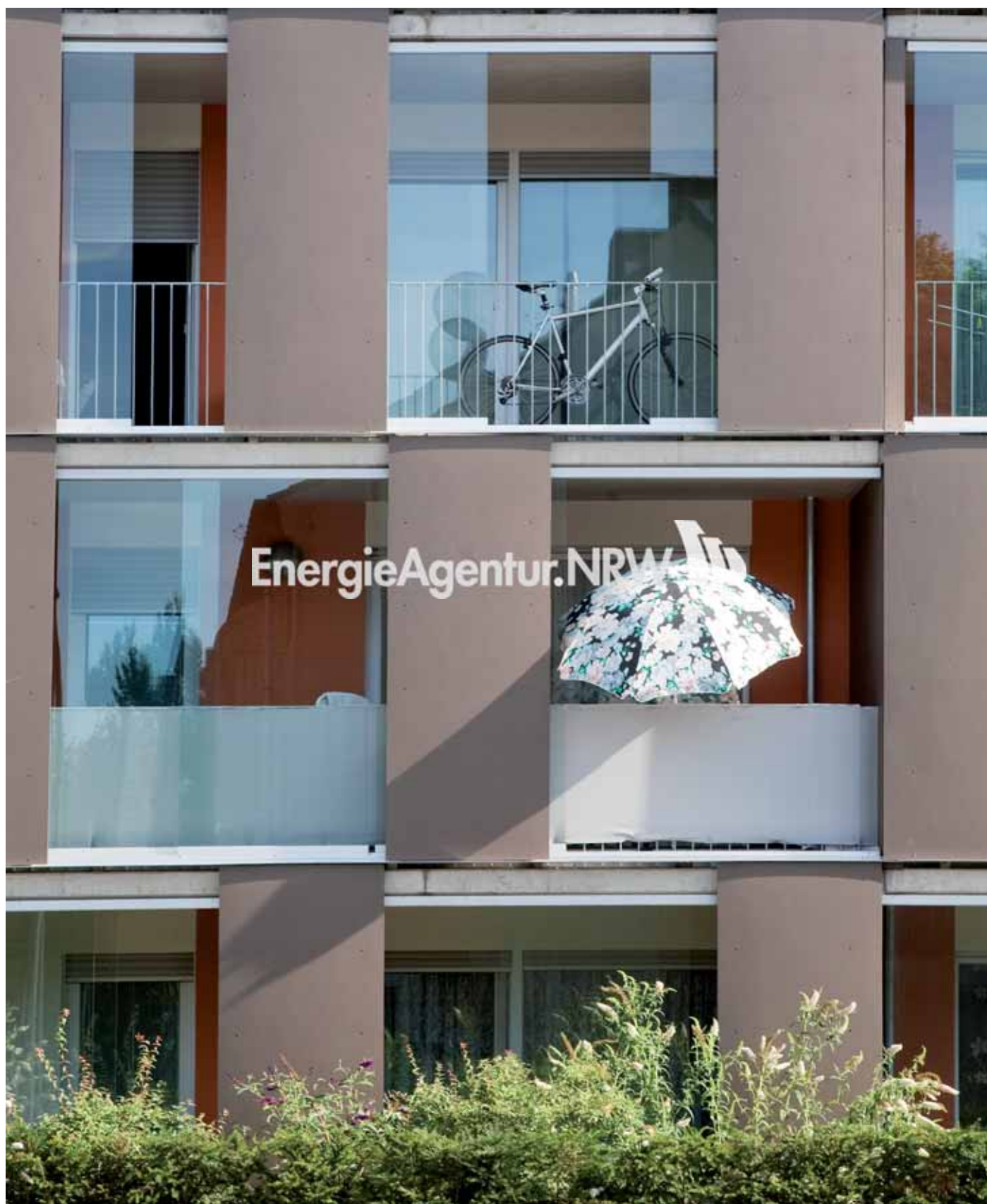
Konstruktiver Sonnenschutz erweitert die Wohnräume
