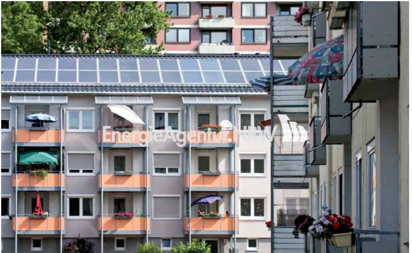
Die südlichen Dächer nutzen die Sonne zur Strom- und Wärmeerzeugung.
