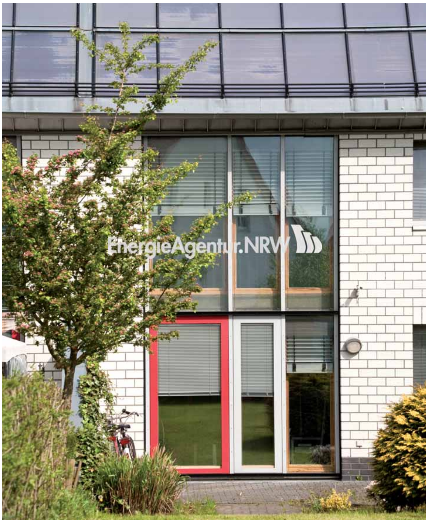
Die vorbildliche Integration der Solarmodule in die Dachflächen.
