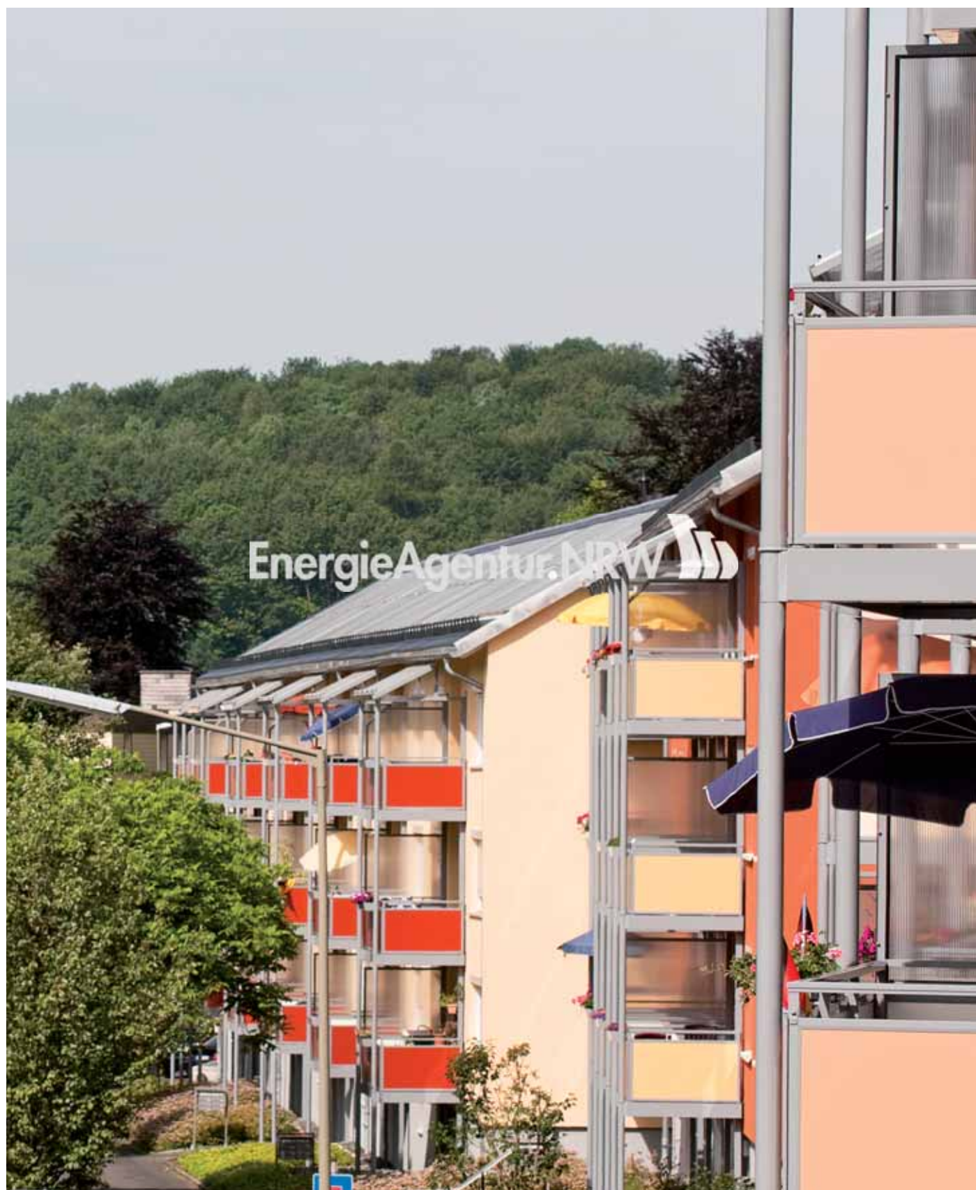
Solarmodule unterstützen die Adresswirkung der Siedlung.
