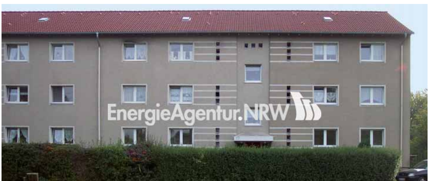
Der Zeilenbau der 60er-Jahre
