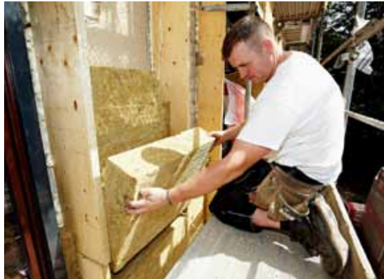
2 Die 300 mm dicke Fassadendämmung „Fixrock 035“ wurde in zwei Lagen zwischen die zuvor montierten Kerto-Träger geklemmt.
