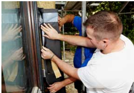
3 Eine sorgsam befestigte und an den Anschlüssen eingeklebte schwarze Fassadenfolie dient als Witterungsschutz und setzt die Schattenfugen der Holzfassade aus hellen Weißtanne-Profilen in Szene.
